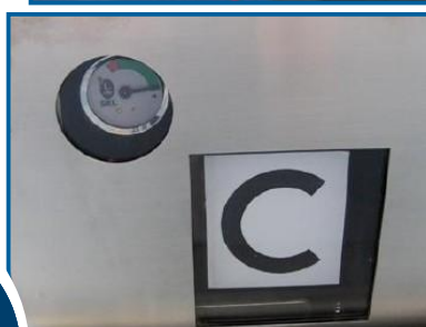
Indicator de stare a separatorului Închis /Deschis
